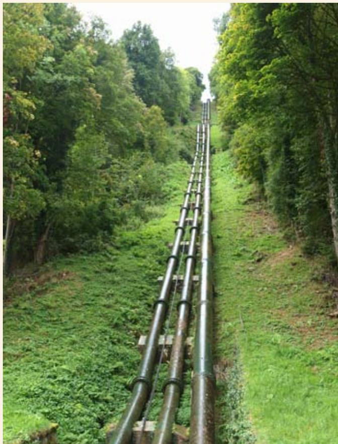
*Les conduites forcées apportent l'eau sous haute pression à une centrale hydroélectrique de Luchon.*
