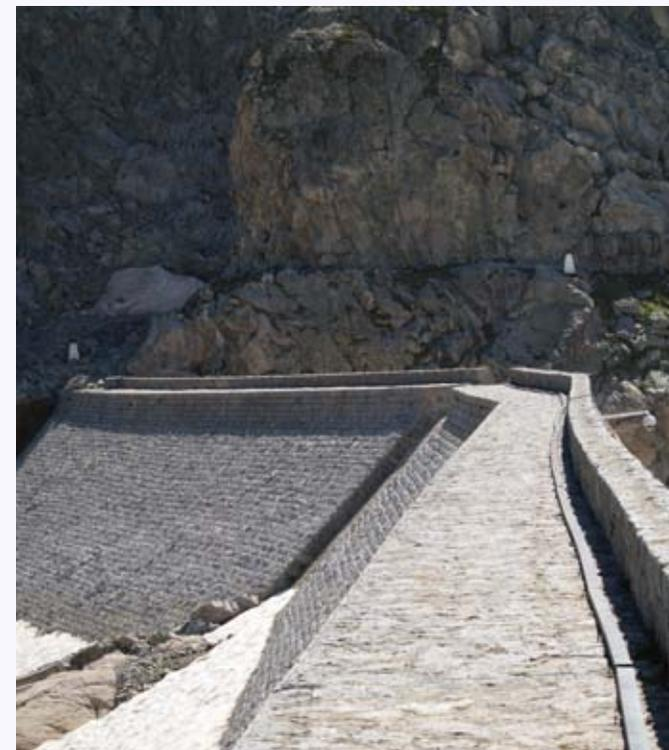
*Le barrage du Portillon mesure 205 mètres de long et a une hauteur maximale de 22,3 mètres. Il a une réserve utile de 16.700.000 m<sup>3</sup>.*
