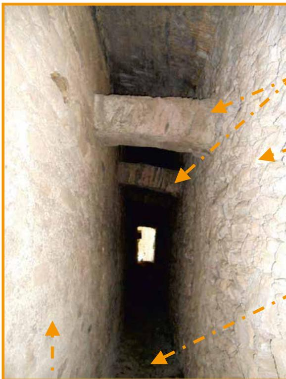
Au Nord, des « *arcs* » sont ancrés dans la roche et viennent renforcer et consolider les murs de l'édifice.
