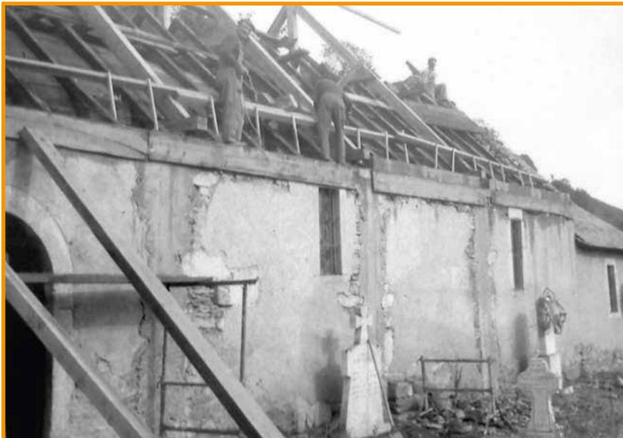
travaux de réfection de la charpente pour la nouvelle toiture
