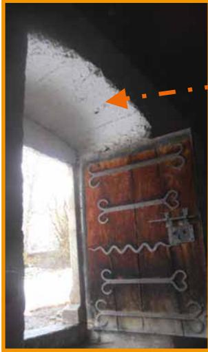
On devine le béton, brut de décoffrage, utilisé pour cette opération.
