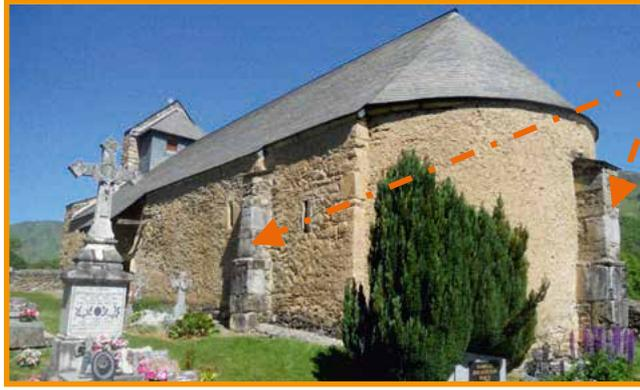
... Les **contreforts** sur les murs extérieurs, démontrent que l'intérieur de l'église était doté d'une voûte en « **berceau** », tant sur la nef que sur l'abside. En effet une fois résolu le problème des « **poussées** » dues au poids des **voûtes** qui se répercutaient sur les murs en les effondrant, désormais les **contreforts** permettent cette nouvelle forme d'architecture.
